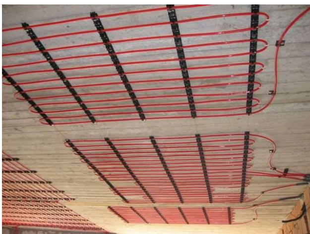
Obr. 31 Stropní vytápění [52]
