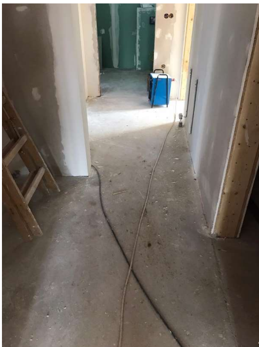
Obr. 37 Fáze III. Dokončená interiérová betonová mazanina (Fotografie autora práce)
