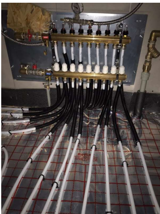
Obr. 43 Detail III. Rozdělovač/sběrač (Fotografie autora práce)
