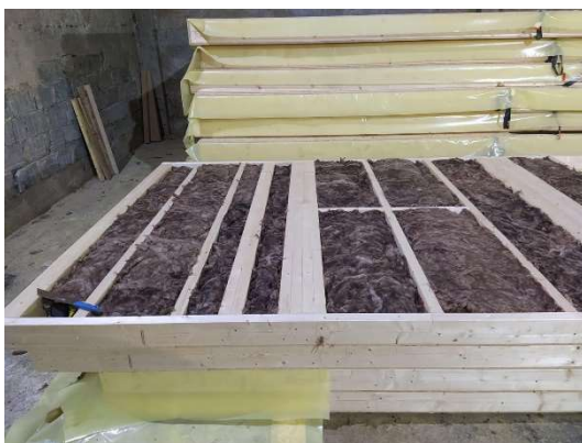
Obr. 7 Panel vyplněný vláknitou izolací (Fotografie autora práce)
