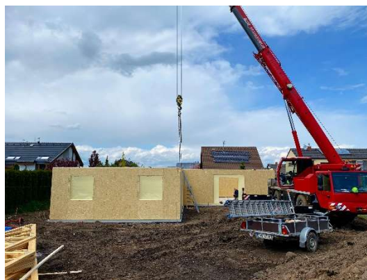
Obr. 8 Montáž panelů za pomoci autojeřábu (Fotografie autora práce)
