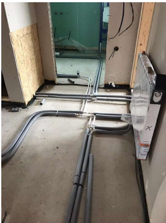
Obr. 35 Fáze I. Montáž rozvodů TP (Fotografie autora práce)
