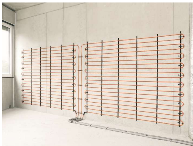
Obr. 30 Stěnové vytápění [51]
