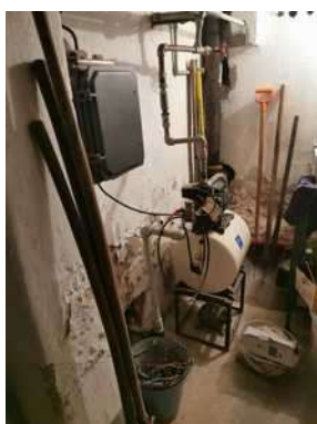
sklep s vodárnou
