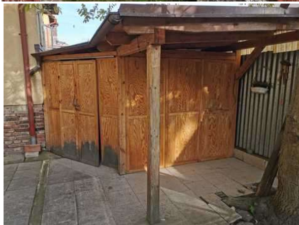
kolna s přístřeškem
