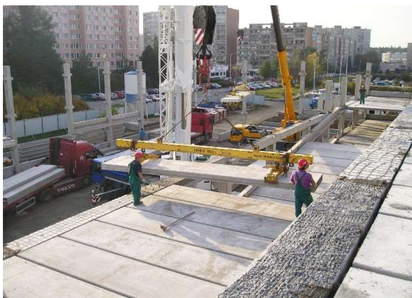
Obr. 3.8 Ukládání dílců rampy [16]
