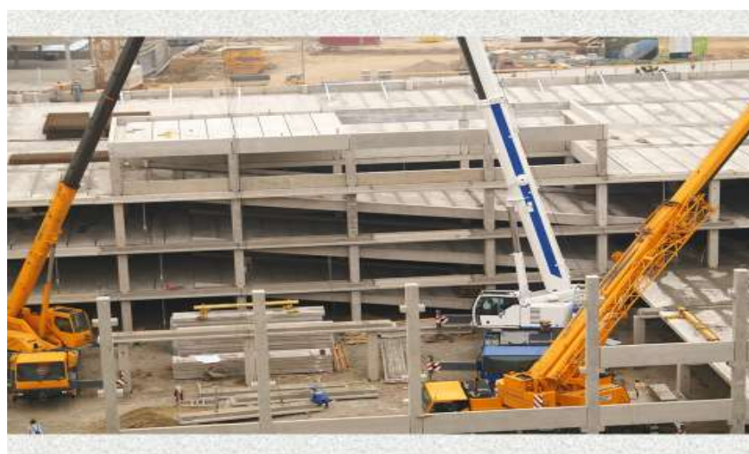
Obr. 3.9 Pohled po uložení betonových dílců rampy [16]
