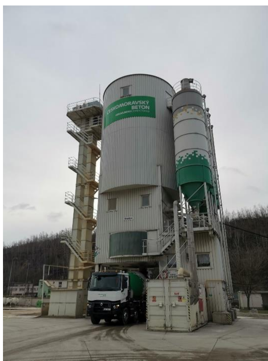
Obr. 5.5: Betonárna ČMB Beroun
