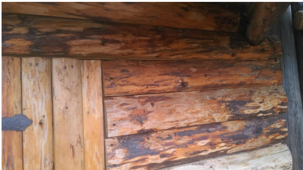
Obrázek 22: Stěna pokrytá krajínami (zdroj vlastní)
