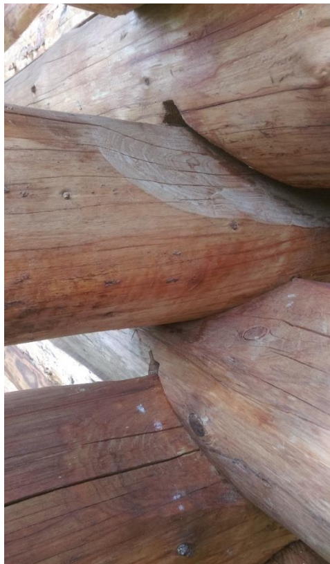
Obrázek 17: Srubové spoje (zdroj vlastní)
