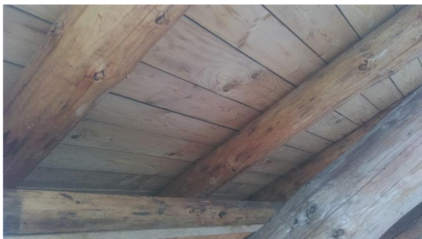
Obrázek 30: Podhled šikmé střechy (zdroj vlastní)
