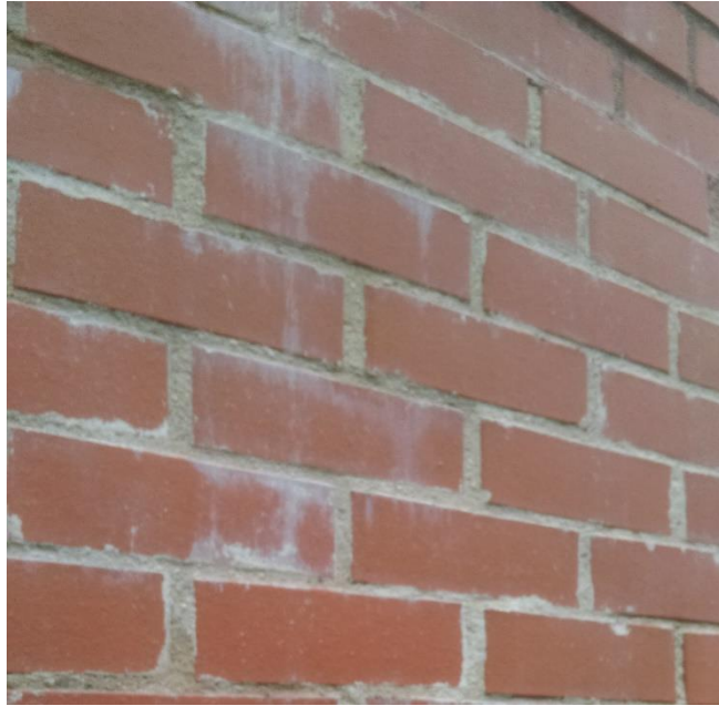
Obrázek 49: Zděná stěna (zdroj vlastní)
