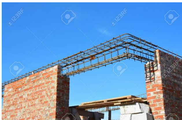
Obr. 2.1 Pohled na výztuž rohového překladu (zdroj: [3])
