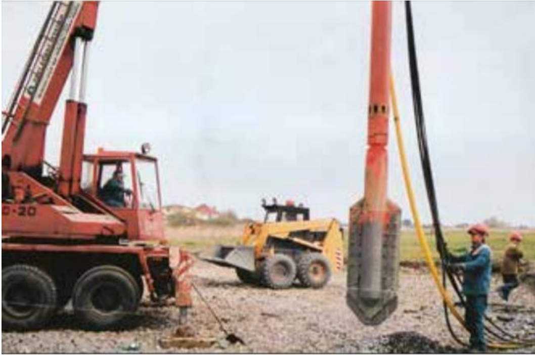
Obrázek 5. Hydraulický ponorný vibrátor [5]
