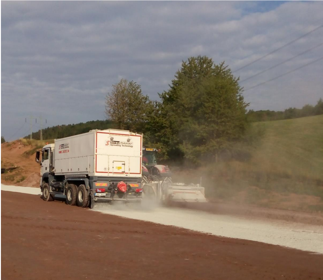
Obrázek 18. Dávkování vápna dávkovacím vozem
