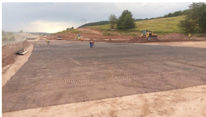
Obrázek 15. Pokládka geomříže na dálnici D6 (Obchvat Řevničov)
