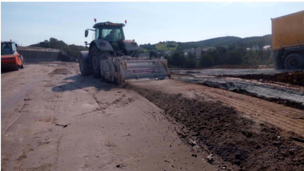
Obrázek 19. Frézování
