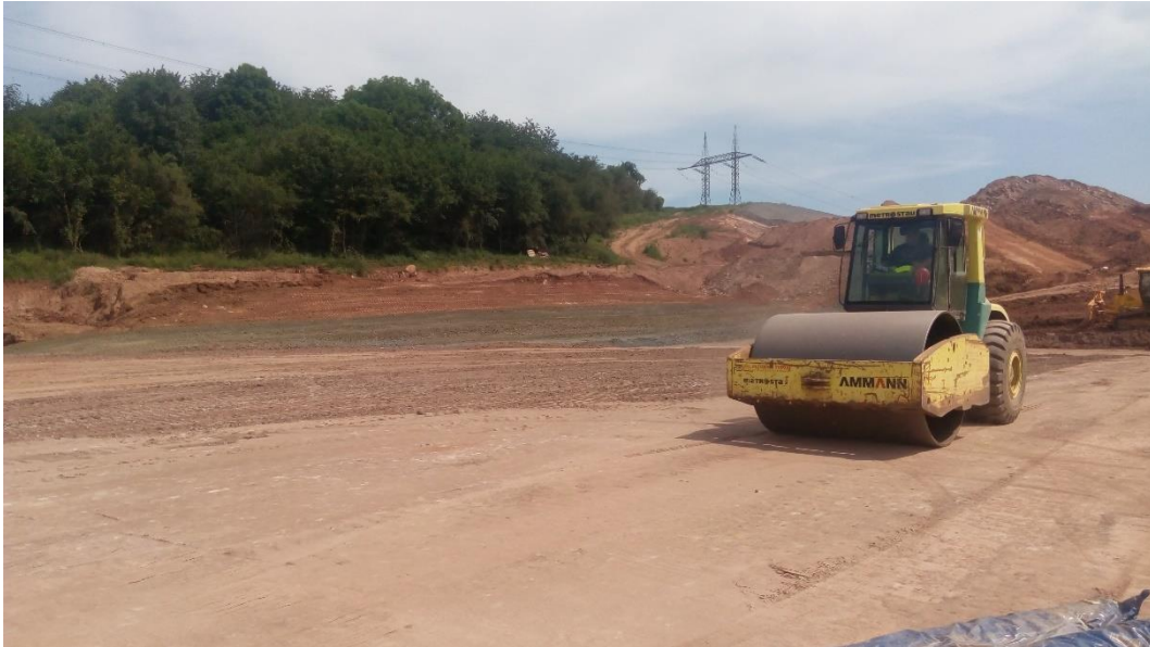
Obrázek 1. Hutnění válcem s hladkým běhounem
