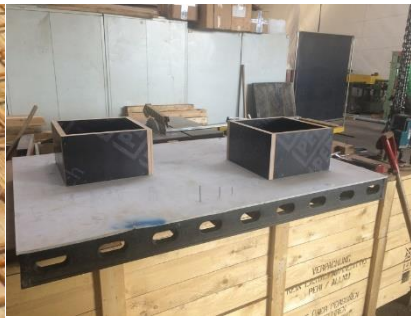
Obrázek 53 Řešení prostupů [zdroj vlastní]
