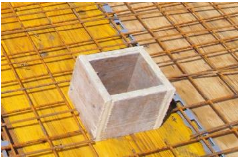
Obrázek 52 Řešení prostupů [16]
