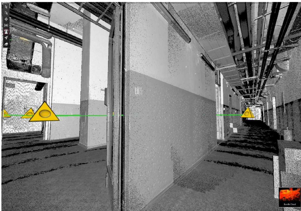
Obrázek 6.5: Ukázka zpracování č. 2 – Leica Cyclone Register 360
