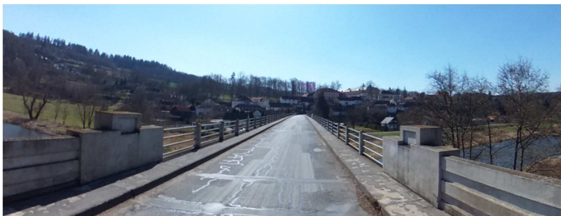
Obr. 2.6 Liblínský most – pohled na mostovku
