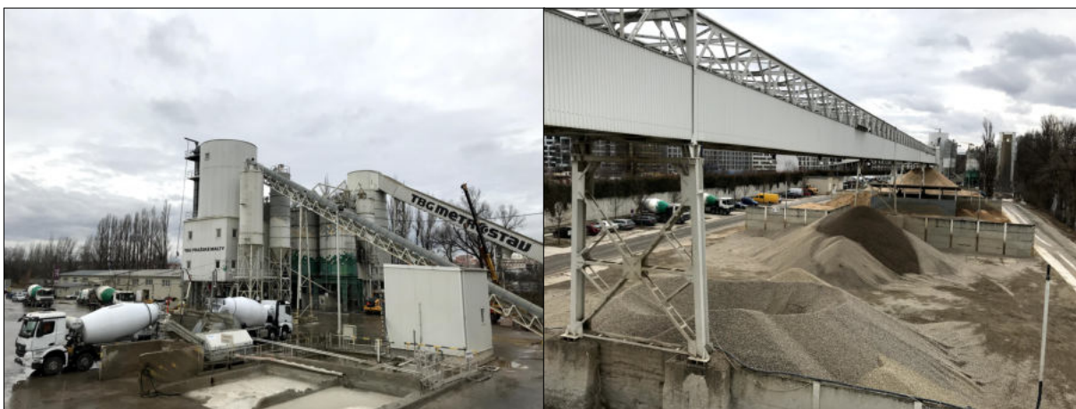
Obrázek C.1: Betonárna na Rohanském ostrově; Deponie kameniva.
