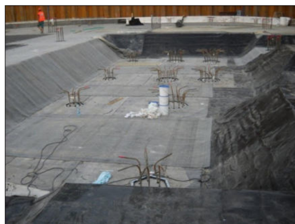
(b) Realizace pokládky těsnících bentonitových rohoží - systém hnědé vany [5].
