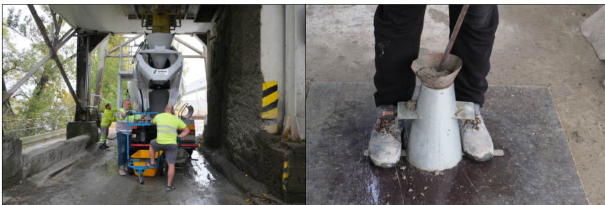
Obrázek C.4: Odběr betonu z autodomíhávače; Zkouška sednutí kužele.
