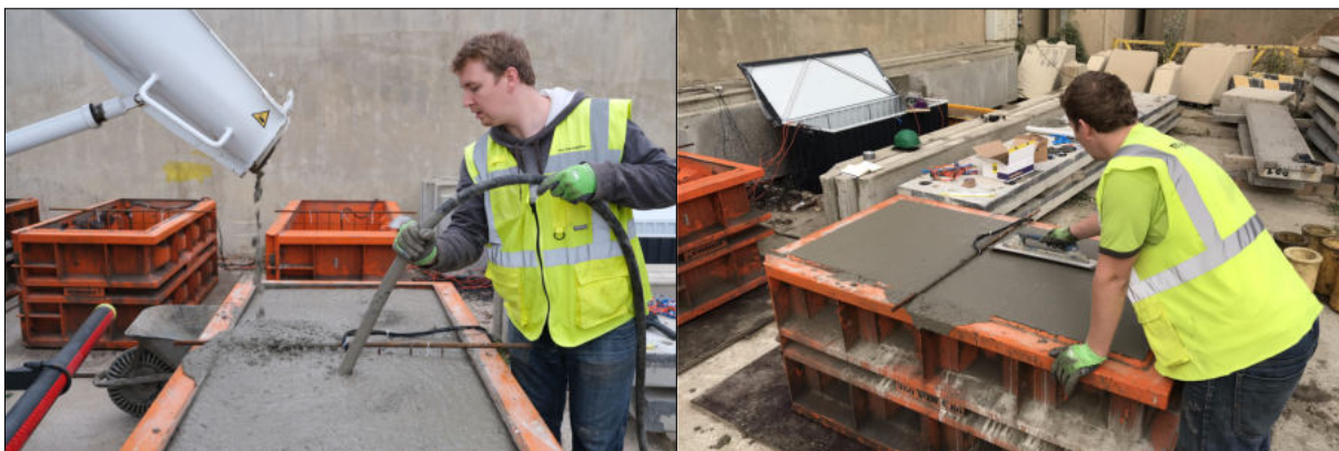
Obrázek C.11: Hutnění betonu ponorným vibrátorem; Uhlazení povrchu betonu.
