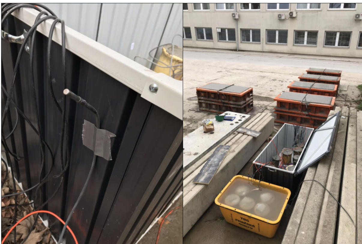
Obrázek C.12: Teplotní čidlo měřící teplotu okolního prostředí; Vybetonované masivní bloky a válce měřící smrštění.
