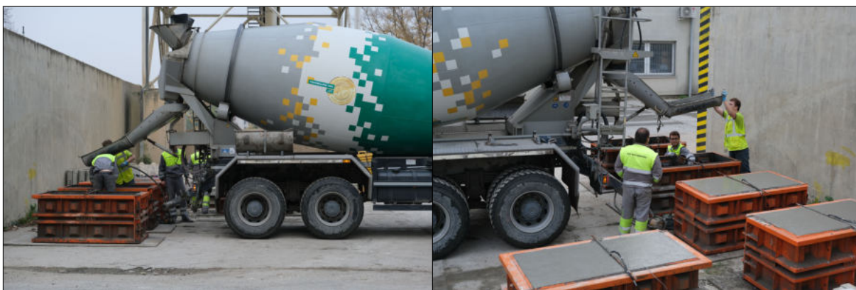
Obrázek C.9: Probíhající práce betonáže masivních bloku k měření vývinu hydratačního tepla.
