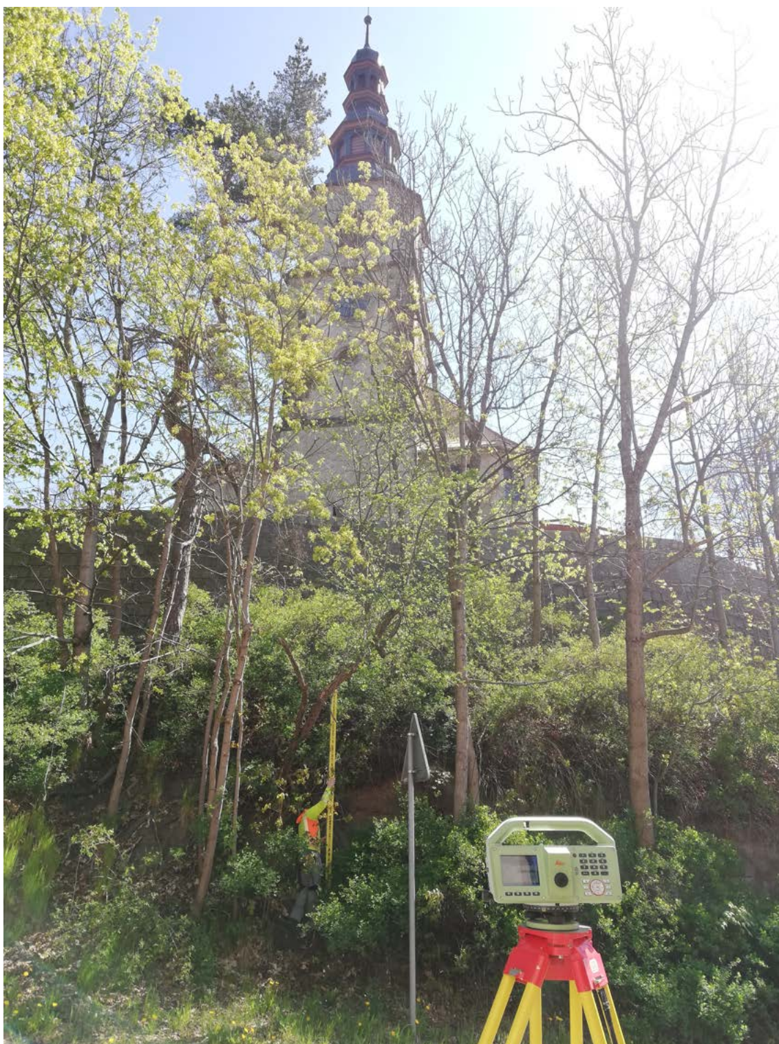
Obr. 3.3: Nivelace na bodu CD-229.1
