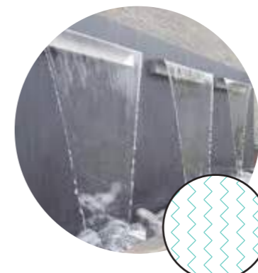
vodní stěna umělý vodopád instalovaný v betonové zdi
