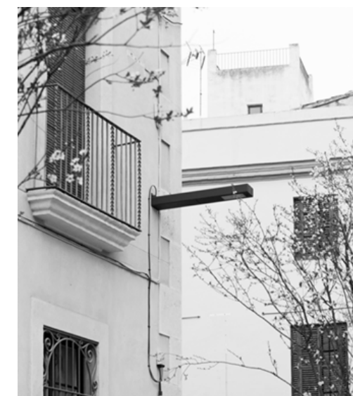
Osvětlení Escofet Bali osvětlení na fasádách domů
