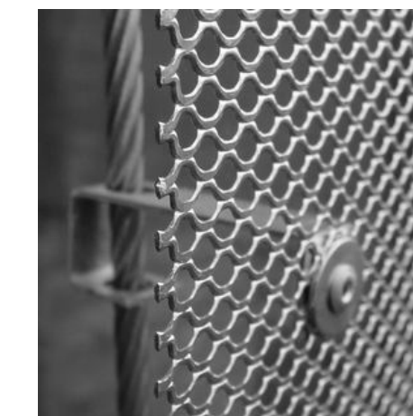
Opláštění venkovního sportoviště Fasádní plech Tecu Sheet Perforovaný, měděný, tl. 3 mm Uchytení na ocelová lanka
