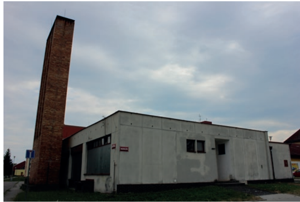
Kotelna sídliště Škorna
