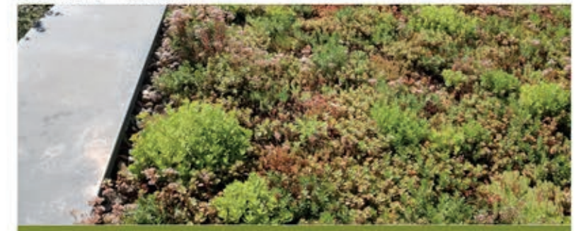
Extenzivní zelená střecha Acre - substrát Acre extenziv 80 - 120 mm)
