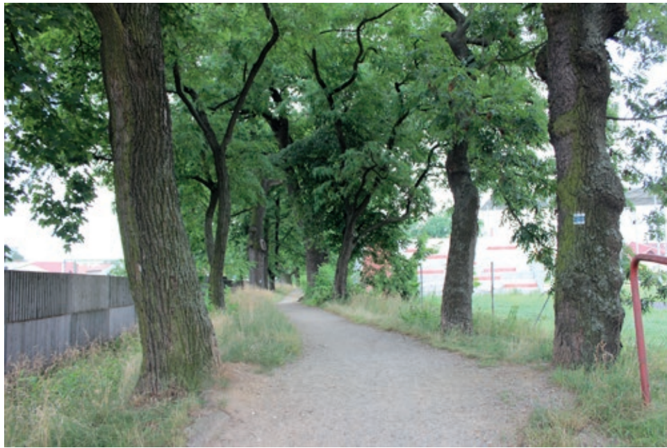
Hráz nádrže Škorna
