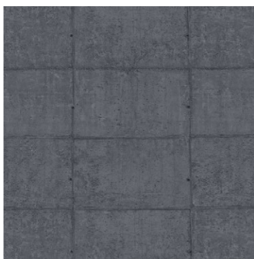
štuk omítka s úpravou
