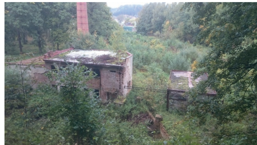
6 Kotelna lázeňského areálu
