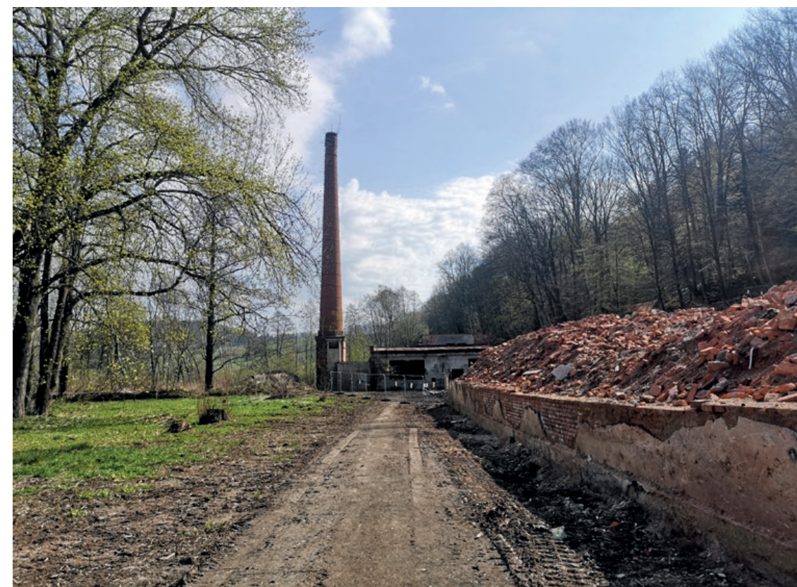
Současný stav areálu po první fázi demolice
