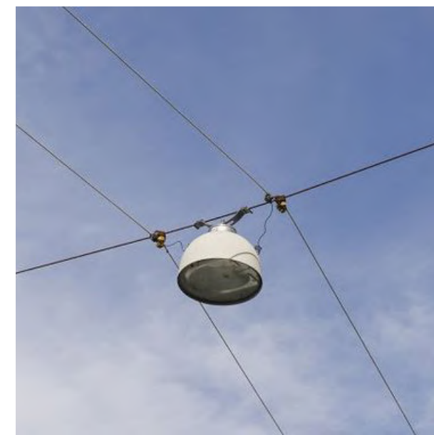
Osvětlení ulic je tvořeno závěsným pouličním osvětlením, kotveným do jednotlivých objektů pomocí ocelových kotev.
