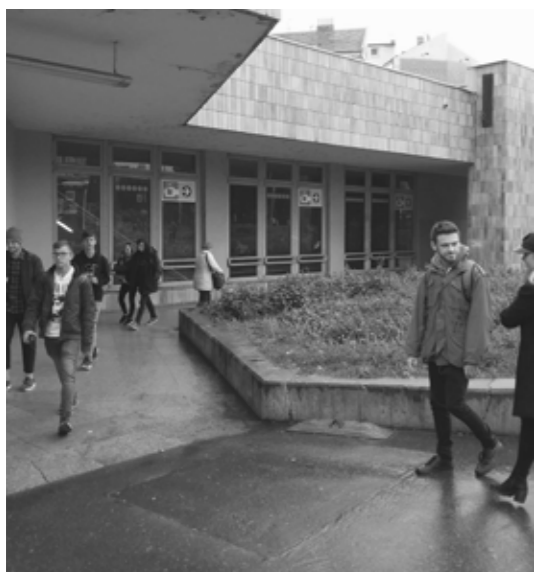
nevhodně řešené frekventované průchody
