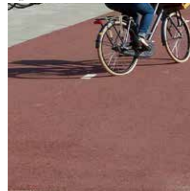
Barvený asfalt - cyklostezska
