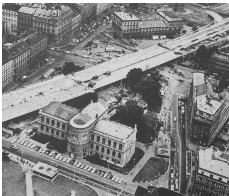
Letecký pohled v průběhu stavby magistrály a metra. (1985)
