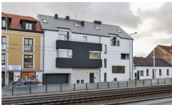
Obrázek 16 - Rezidence Malý Břevnov
