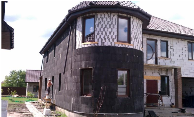
Obrázek 25 Zateplení pomocí Pěnového skla
