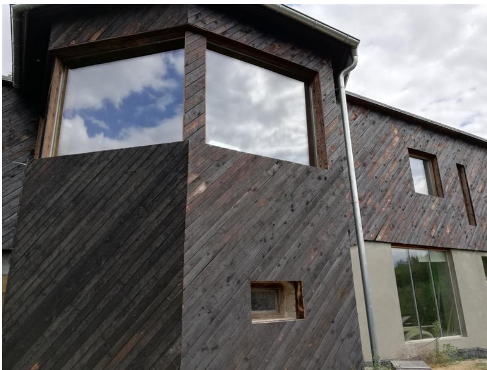
Obrázek 8: Fasáda domu z opalovaného modřínu
