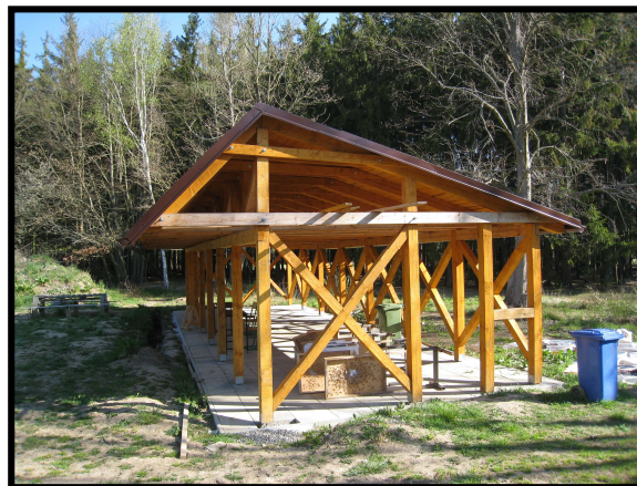
obrázek č. 45: Zastřešení střeleckého stanoviště
