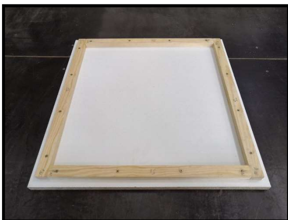
obrázek č. 32: Připravené bednění
