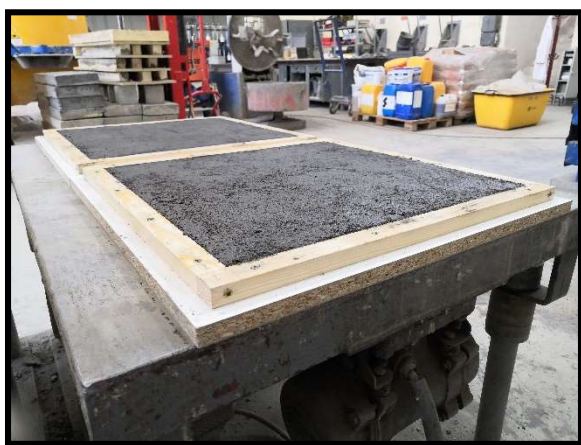
obrázek č. 38: Vybetonované desky
