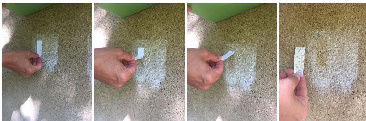
Obr. 81 Provádění „Scotch Tape“ testu in-situ – předem připravené a označené lepicí pásky jsou přitlačeny k povrchu materiálu a poté opatrně sejmuty (kolmý úhel odtrhu) a umístěny do transportního sáčku
