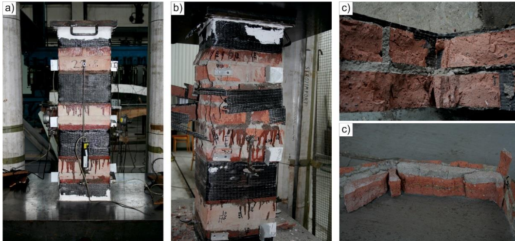
Obr. 14: Zesílený cihelný pilíř (a), porušení zesíleného cihelného pilíře (b), porušená tkanina s povrchovou částí zdiva (c)
