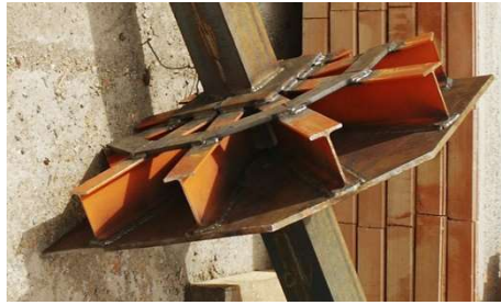
Obr. 18 Skrytá ocelová hlavice (zdroj: [11])
