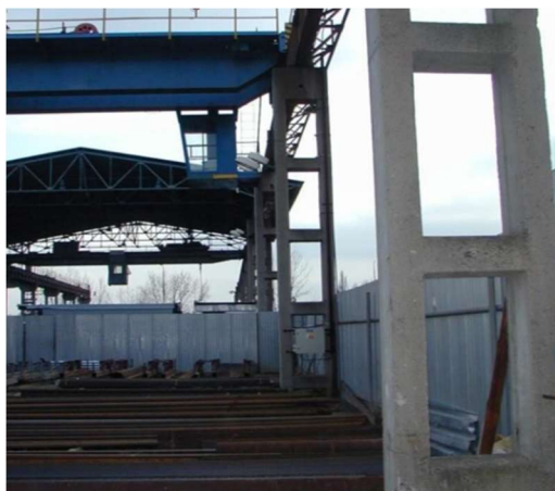
Obr. 2.2 Ukázka Vierendeelova sloupu s vodorovnými příčkami [25]
