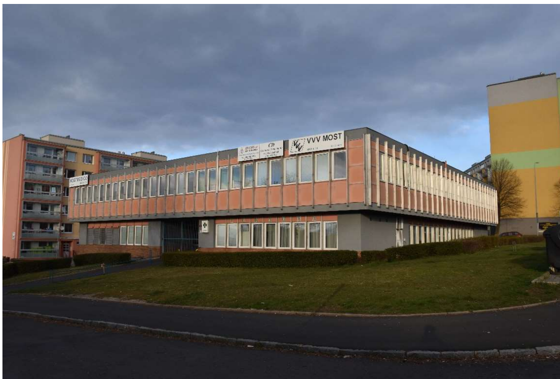
Obr. 3 – Boční pohled na budovu zdravotního střediska
