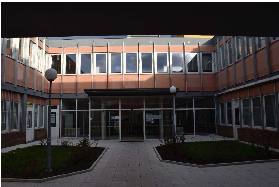
Obr. 4 – Pohled na vnitřní atrium budovy
