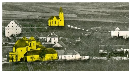
fig D—45 Výřez z jiného archivního snímku, pořízeného dříve a ze stanoviště více vlevo než u uvedené pohlednice. Představuje skutečnou podobu uplatnění stavebních dominant v místech, která byla na pohlednici pozměněna retuší (pravděpodobně při zákresu školy, jejíž pohledové uplatnění neodpovídá dobové skutečnosti – viz bílý rámeček na fig D—44).
