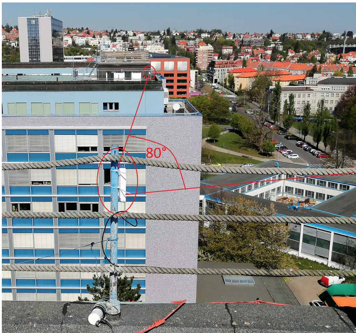
Obrázek C.10: Fotografie umístění antén na střeše ČVUT FEL, foceno z bloku B3. AP jsou vyosené vůči sobě, anténa na bloku B3 je natočená přibližně o 80^\circ
