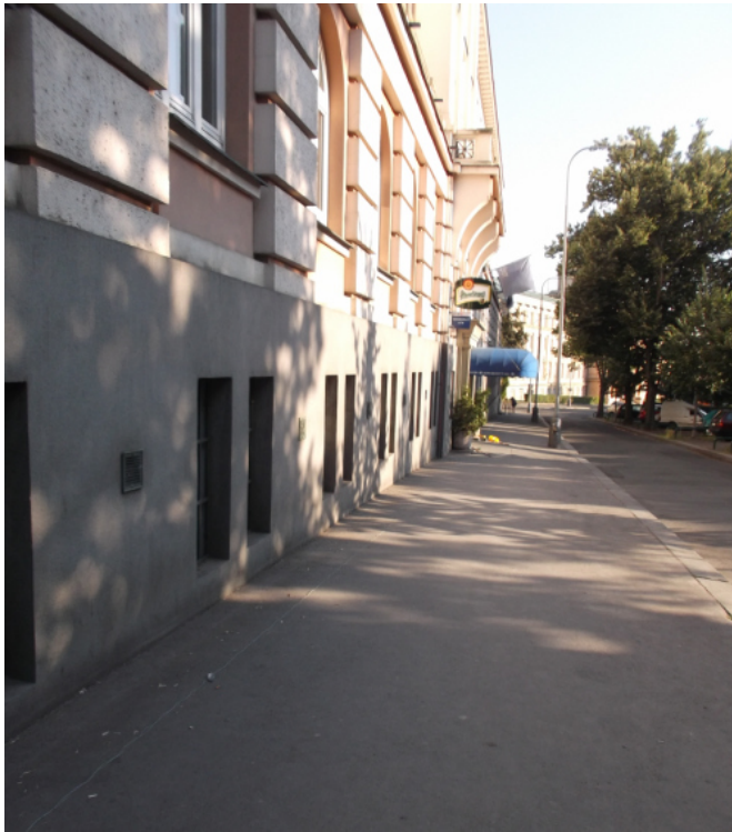
Obr. č. 5.3.4 Pohled na záměru podél budovy Masarykovy koleje
