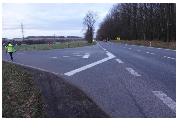
Obrázek 29 – Detailní pohled na současnou realizaci VDZ v křižovatce. [29]
