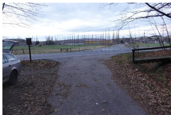
Obrázek 28 – Vyústění sjezdu účelové komunikace, pohled do křižovatky. [29]
