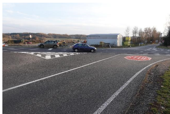
Obrázek 36 – Silnice II/270, pohled ve směru proti staničení silnice. [29]
