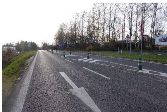
Obrázek 37 – Detailní pohled na realizaci DZ Z 11h „Baliseta“. [29]
