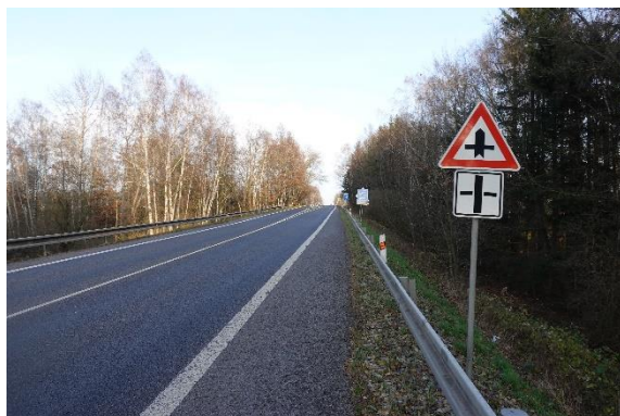
Obrázek 33 – Silnice I/13, pohled ve směru staničení silnice. [29]
