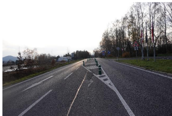
Obrázek 34 – Silnice I/13, pohled ve směru proti staničení silnice. [29]
