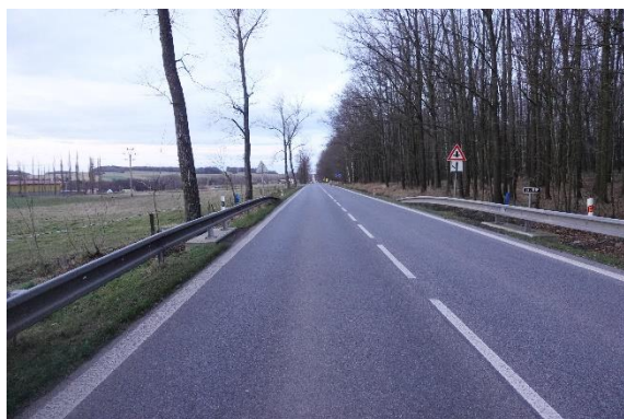
Obrázek 25 – Silnice I/13, pohled ve směru staničení silnice. [29]
