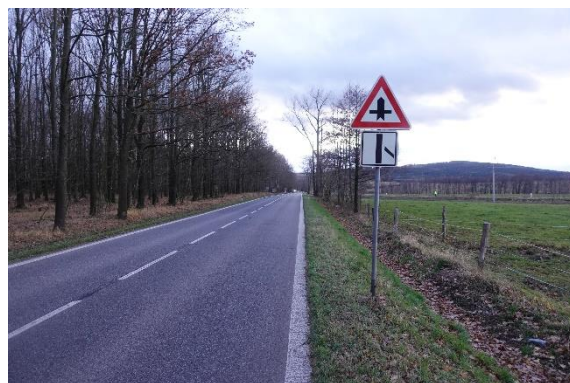
Obrázek 26 – Silnice I/13, pohled ve směru proti staničení silnice. [29]
