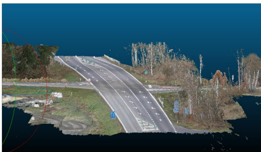
Obrázek 45 – Křižovatka I/13x II/270, pohled ze severovýchodu na jihozápad.
