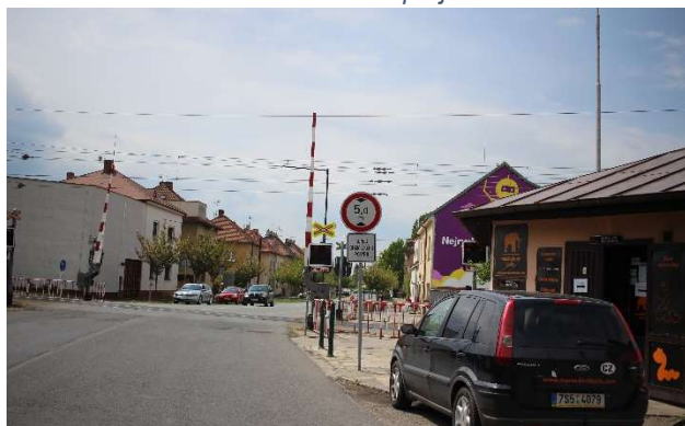
Obrázek 8: Železniční přejezd P4949
