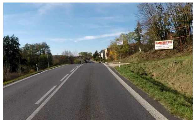
Obrázek 57 – Vjezd do obce ve směru proti staničení silnice I/22. [29]
