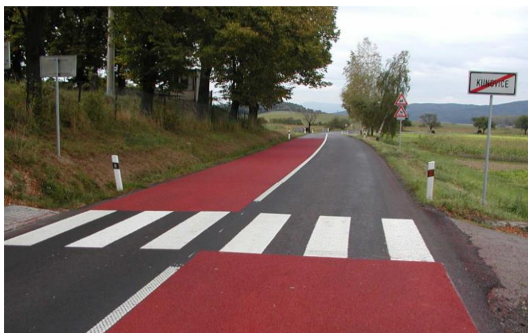
Obrázek 24 – Ukázka změny povrchu vozovky před vjezdem do obce. [25]
