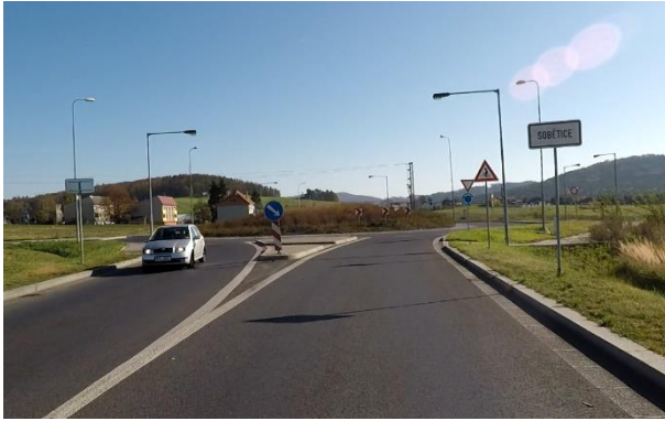
Obrázek 48 – Pohled na okružní křižovatku před západním vjezdem do obce Soběstice. [29]
