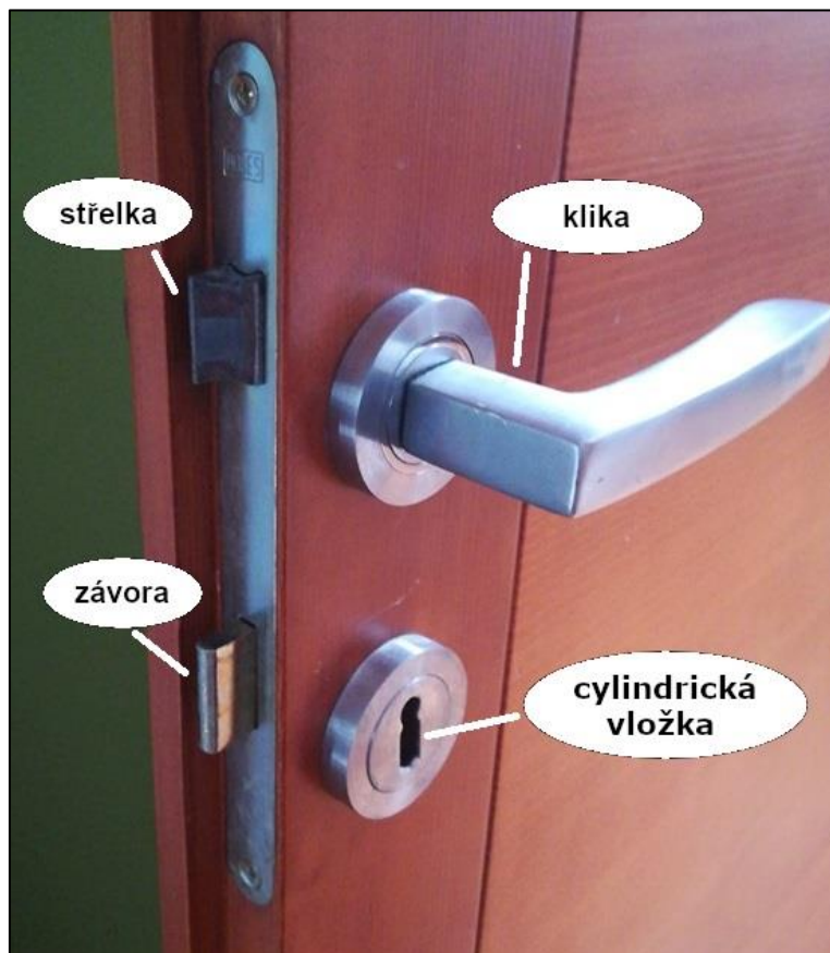
Obrázek 8: Konstrukce zámku s cylindrickou vložkou (foto autor 2020)
