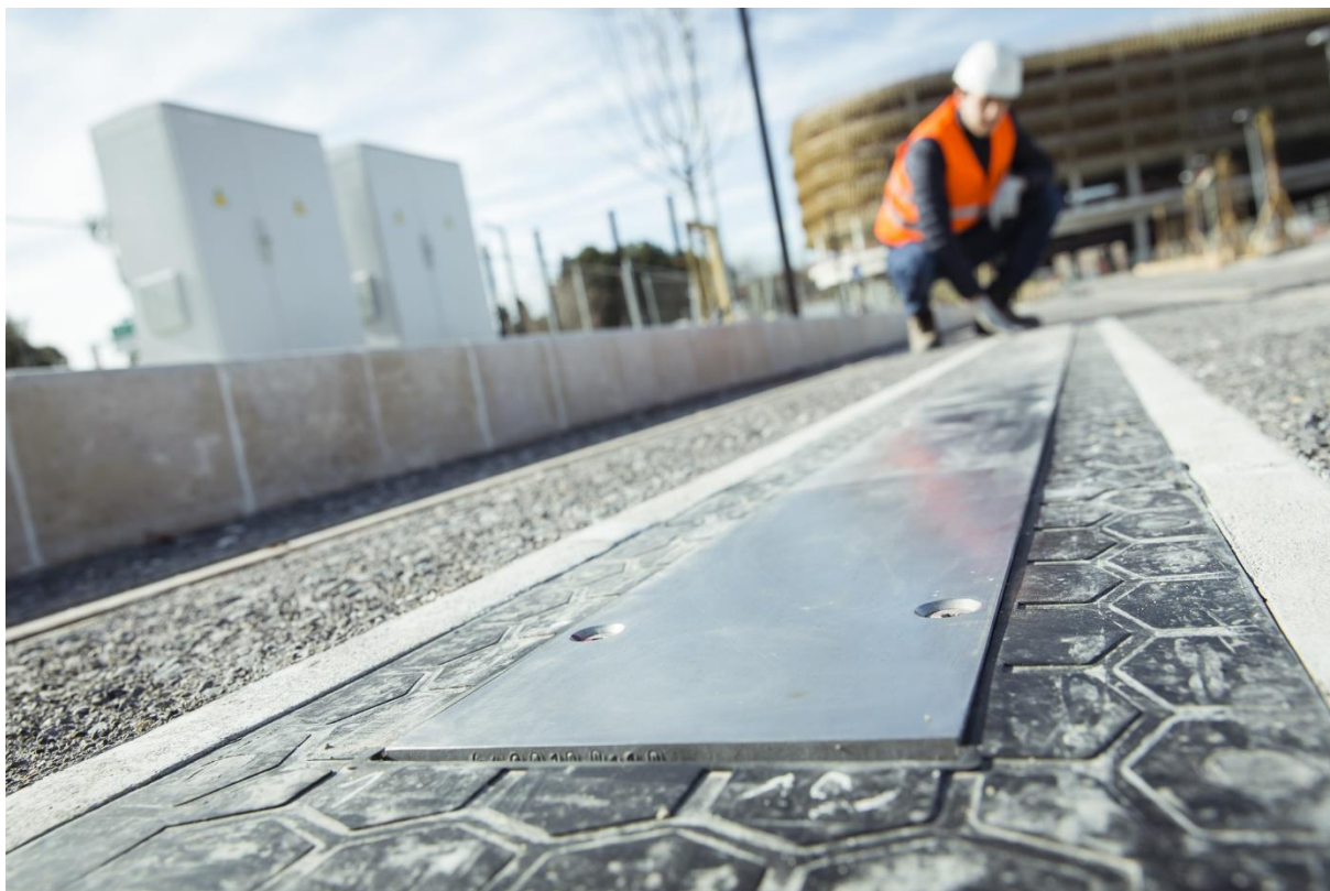
Obrázek 12 Zařízení SRS pro statické dobíjení tramvají v Nice [31]
