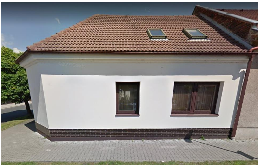
Obrázek 5.1 – Snímek strany domu orientované na jihozápad
