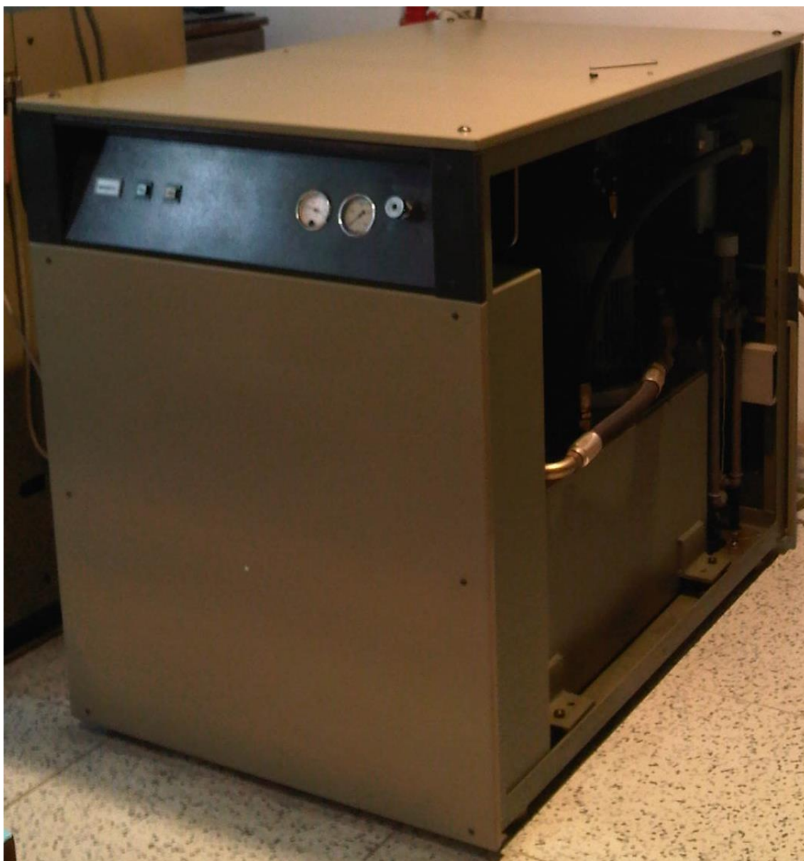
Obrázek 6: Hydroagregát před modernizací v roce 2019
