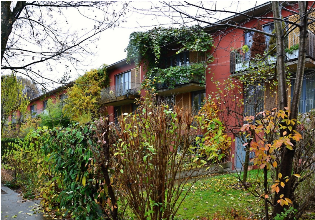
Dům je obklopen neoplocenou zahradou se vstupy do jednotlivých domů. Zdroj foto: autorka
