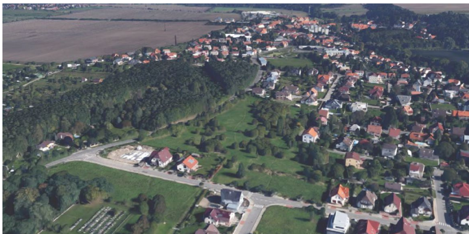
Pohled na místo stavby v původní podobě. Zdroj foto: mapy Google.
