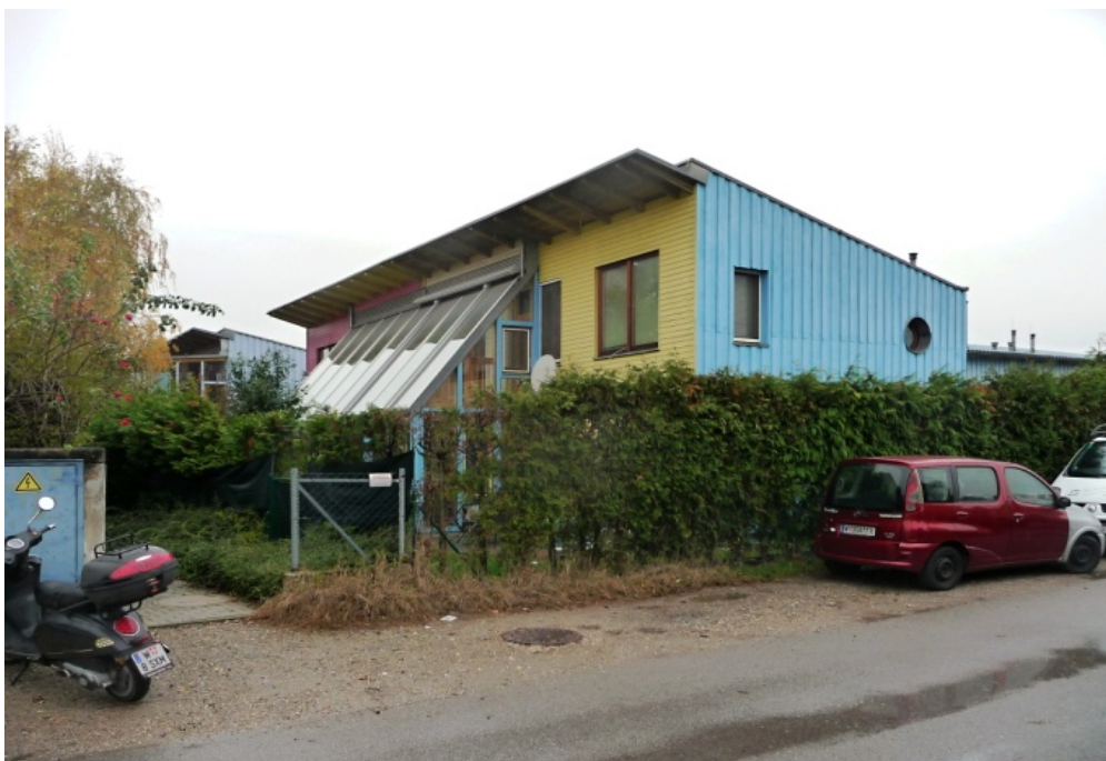
Pohled z ulice na jižní fasádu se zimní zahradou. Zdroj foto: autorka
