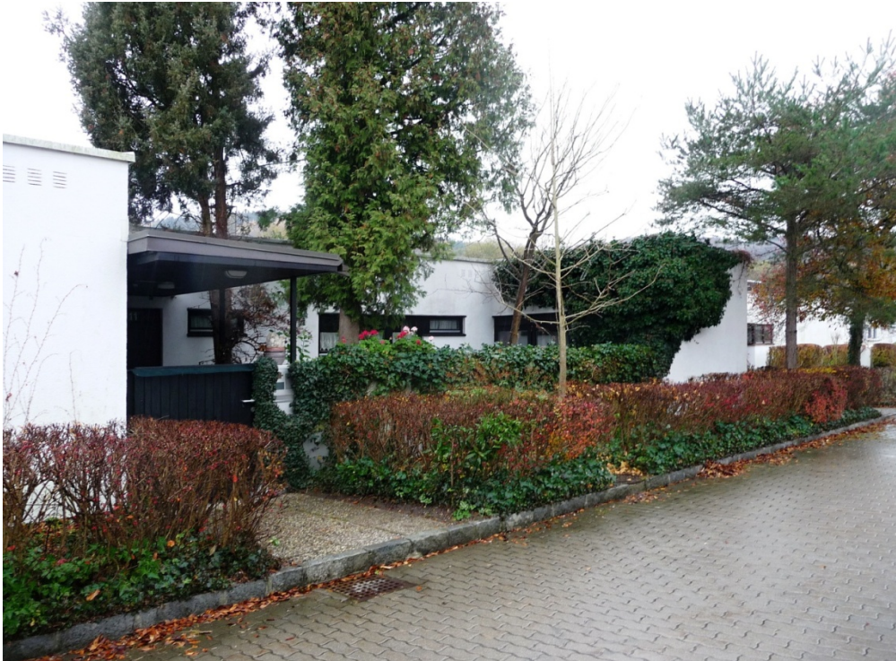
Atriový dům při hlavní servisní cestě - 2. etapa výstavby.
