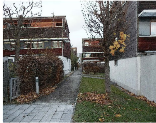
Linz: Wimmer, Wohnen in Harbach
