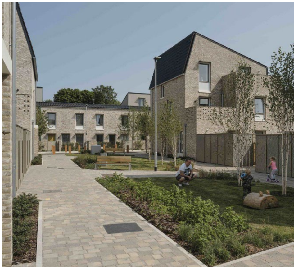
Projekt dostupného bydlení v Goldsmith Street, Norwich, od architektů Mikhail Riches a Cathy Hawley, zdroj fotografií: Tim Crocker, http://www.mikhailriches.com/project/goldsmith-street/
