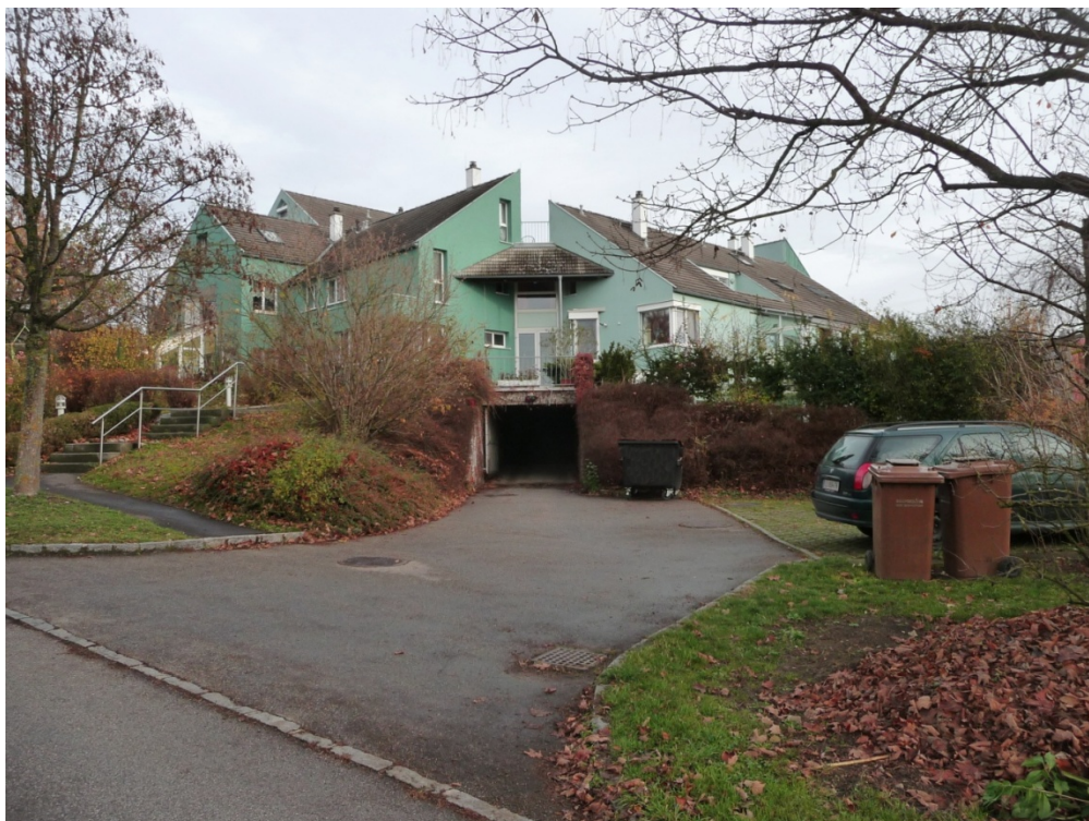
Příjezd k objektu, vjezd do podzemních garáží pod objektem.
