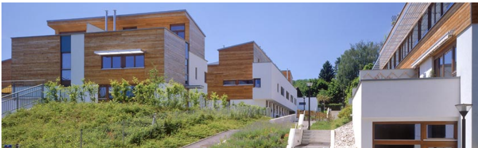
Fotografie stavu krátce po dokončení výstavby. Zdroj foto: awimmer.at
