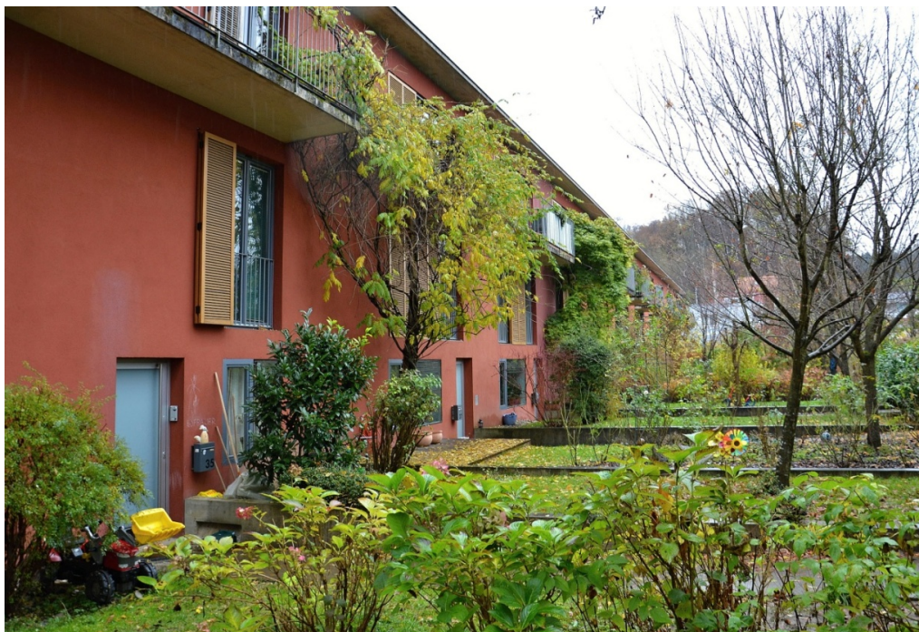
Pohled na stavbu z ulice, s oddělenými mírně zapuštěnými vstupy do jednotlivých řadových domů. Zdroj foto: autorka
