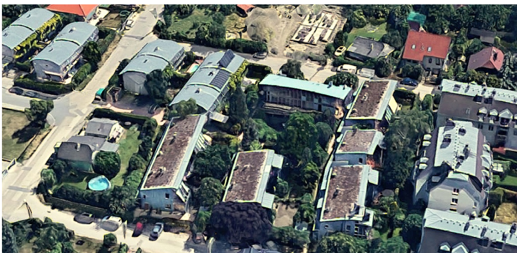
Letecký pohled na stavební soubor: uprostřed pět řadových domů a společenský objekt podle návrhu skupiny Arge.
