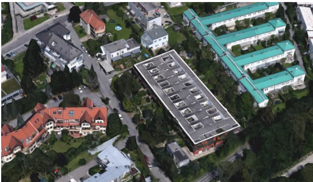
Letecký pohled na dům uprostřed snímku (zdroj: Google maps)
