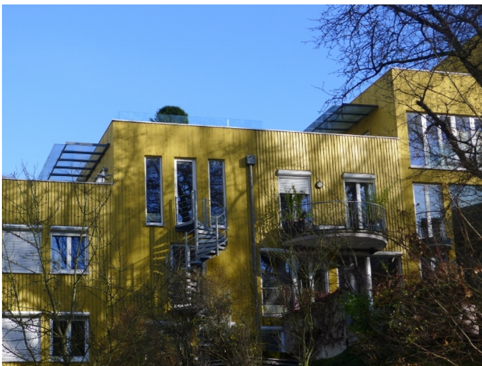
Jednotlivé obytné jednotky jsou individualizované, včetně fasády. Zdroj foto: autorka
