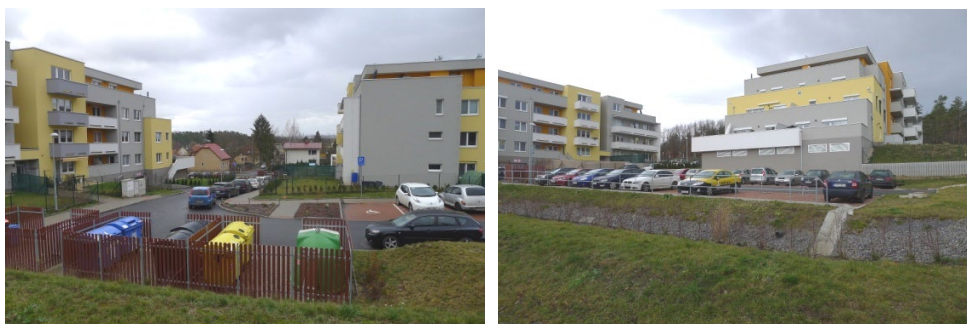
Fotografie postaveného projektu. Zdroj foto: autorka
