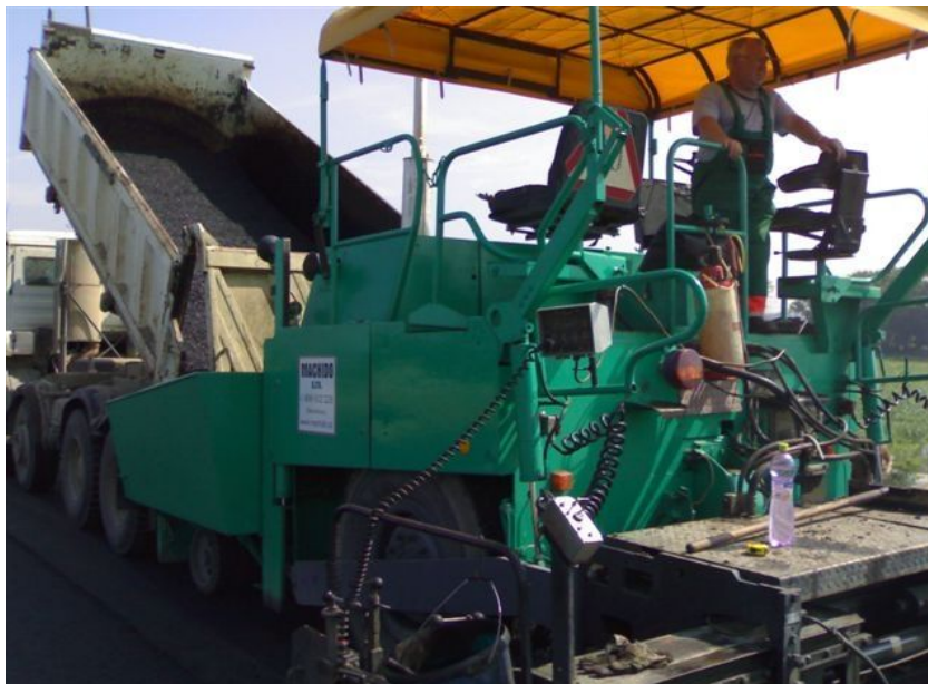
Obr. 8: Plnění finišeru horkou asfaltovou směsí
