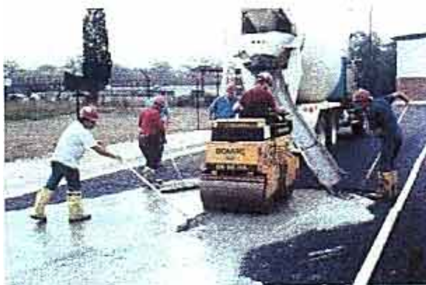
Obr. 11: Vibrování, roztírání a hlazení rozlité vrstvy výplňové malty [7]
