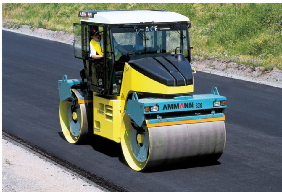
Obr. 9: Válcování položeného asfaltového koberce
