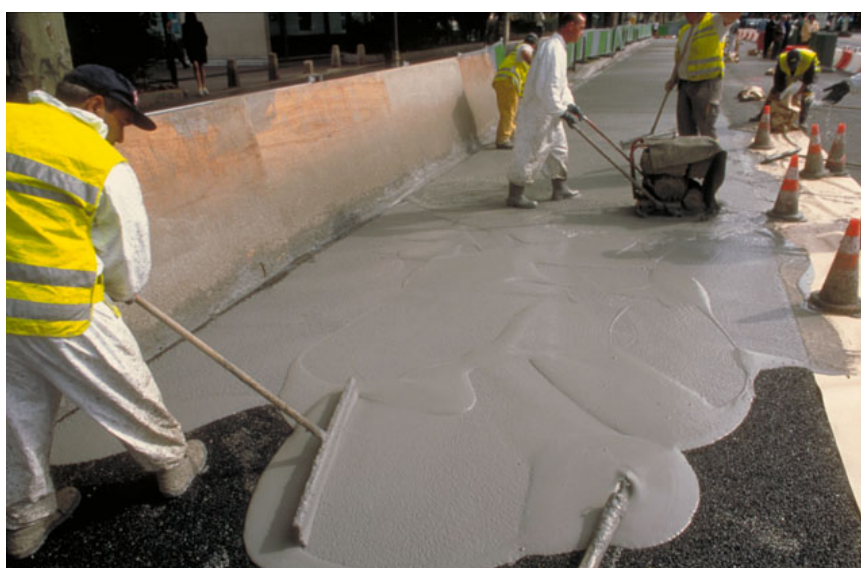
Obr. 4: Aplikace gumových stěrek při zalévání cementové suspenze
