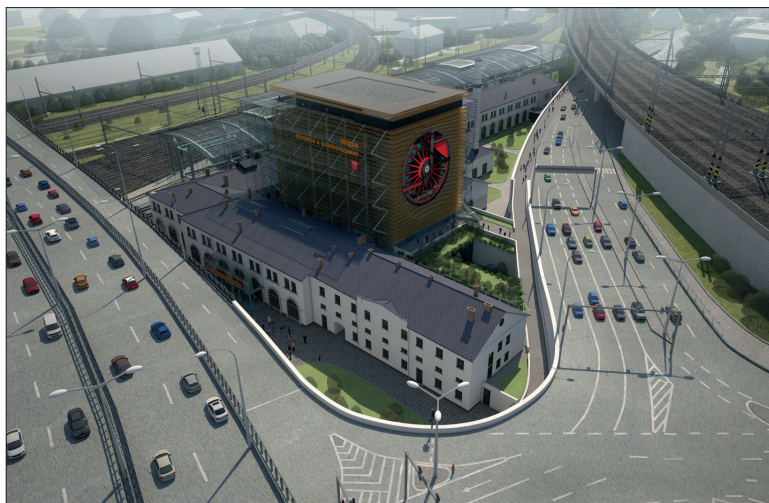
Obr. 1. Budova Muzea železnice a elektrotechniky od křižovatky U Bulhara
