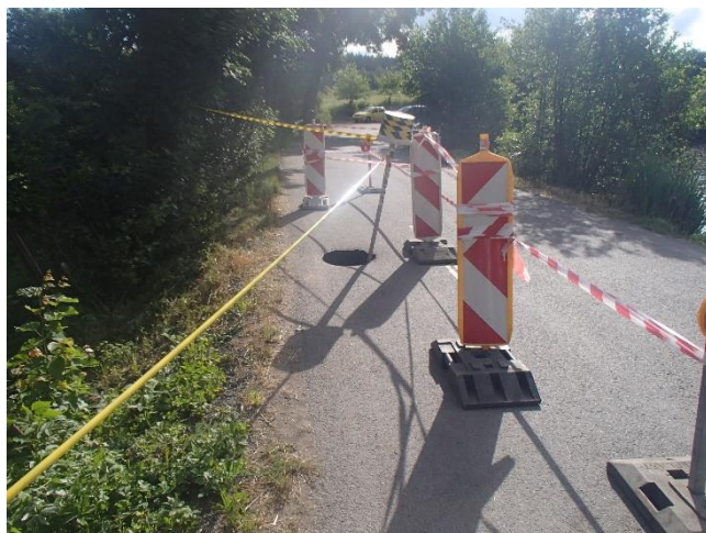
Obr. 4 Kaverna v tělese hráze (Foto S.Žatecký).
