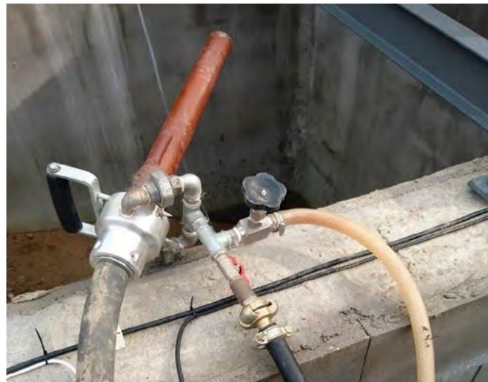
Obr. 7. Tryska pro aplikaci bentonitu technologií stříkání
