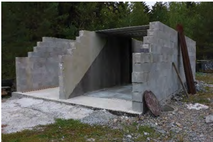
Obr. 2. Objekt pro experimentální testování modelů hrází v reálném měřítku. Na zdi sekce v popředí je patrná hydroizolace, v pravé části snímku lze vidět prostor pro instalaci nádrže k jímání vody prosakující tělesem hráze
