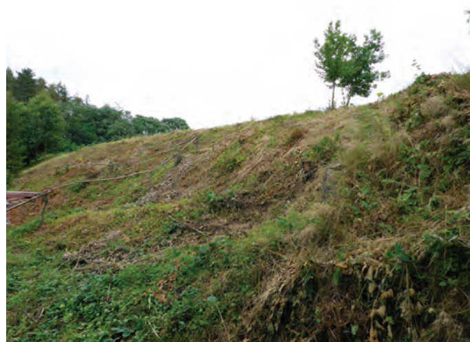
Obr. 9. Vzdušný líc hráze Podbečvářského rybníka
