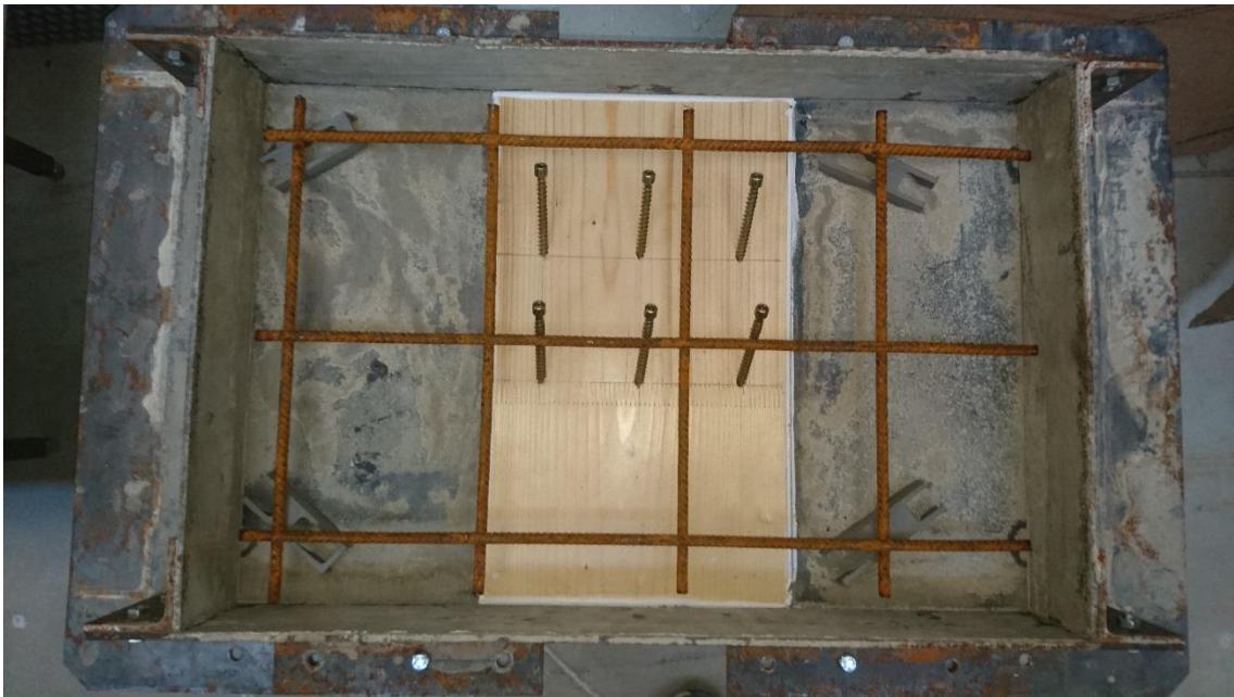
Obrázek 6.5 - Uložení výztuže do formy
