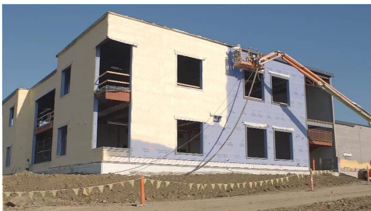
Obrázek 38 Aplikace stříkané pěnové izolace [ICYNENE]
