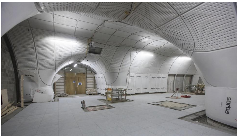
Obrázek 60 Betonové panely v londýnském metru [69].
