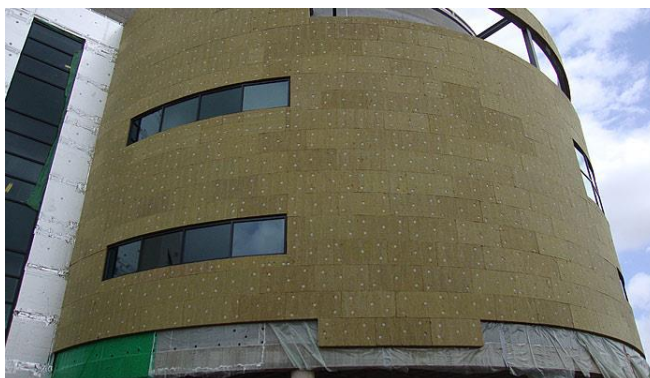
Obrázek 37 Tepelná izolace [Wetherby Building Systems Ltd]
