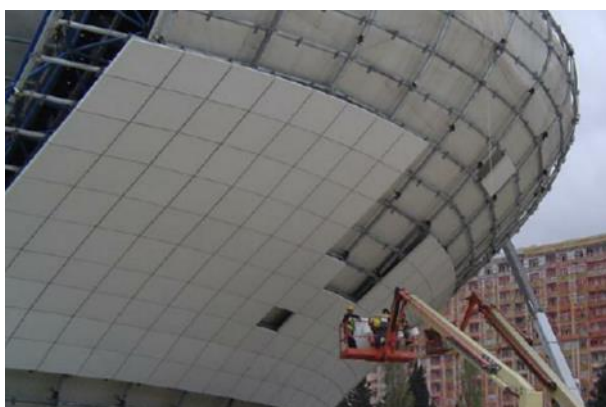
Obrázek 41 Montáž fasády Heydar Aliyev Centre [46]
