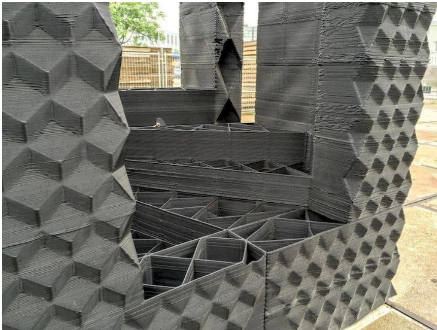
Obrázek 54 Velkoformátové panely vytištěné na tiskárně KamerMaker [Fabbaloo, DUS Architects]
