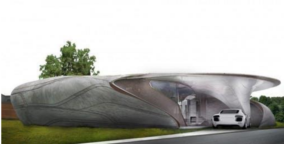
Obrázek 33 Návrh stavby vytvořené technologií 3D tisku z plastu ABS vyztuženého karbonem [64]
