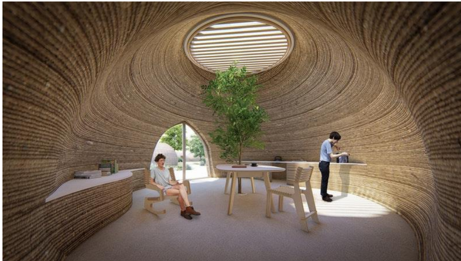
Obrázek 20 Ekologický dům "TECLA", otvor na stropě jako řešení vrchlíkového efektu [22]
