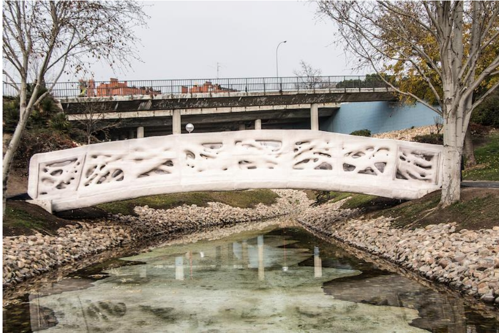
Obrázek 18 3D tištěný most v Madridu [21]
