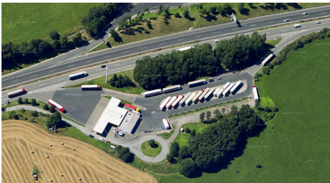
Obrázek 28 - Odpočívka Humpolec vlevo - stav před rekonstrukcí [18]
