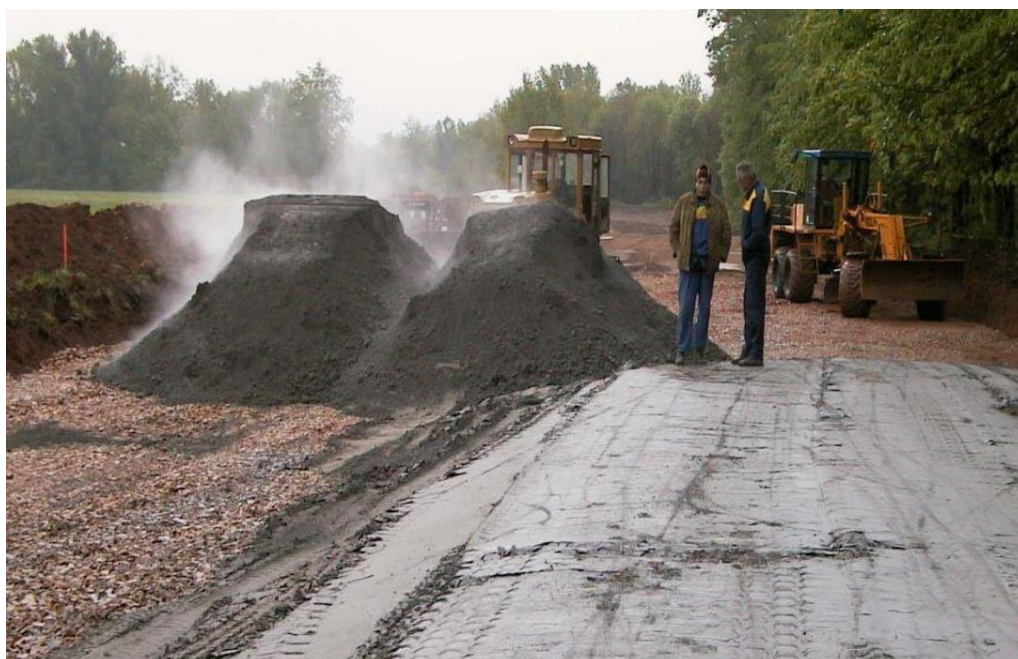
Obrázek 23 - Provádění protipovodňové hráze [19]
