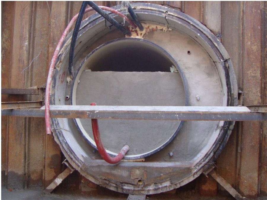
Obrázek 19 - Výplň mezikruží kanalizace pomocí CPS 3,5 [30]
