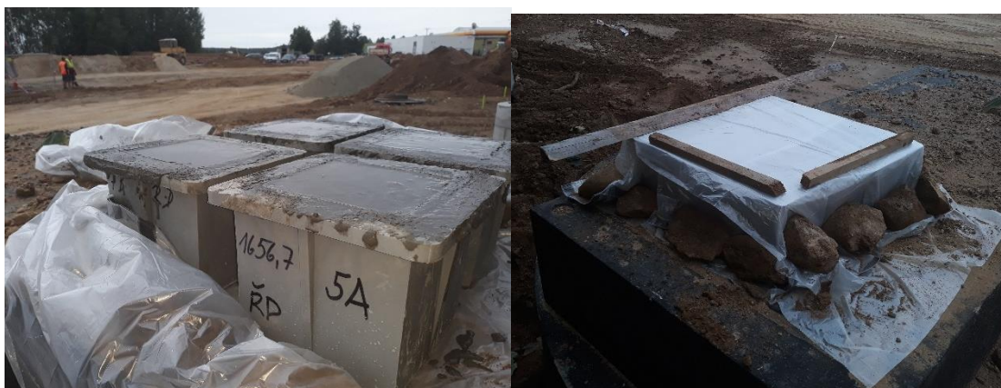
Obrázek 33 - Odběr zkušebních těles v místě stavby
