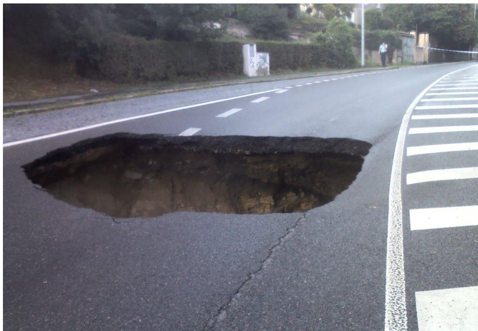
Obrázek 13 - Propad komunikace [11]
