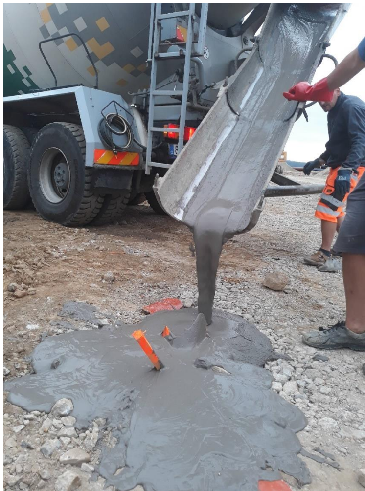
Obrázek 32 - Zvolený postup výplně potrubí cementopopílkovou suspenzí
