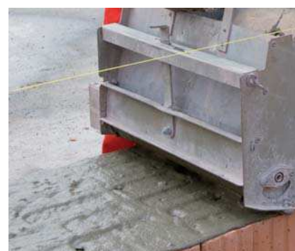
celoplošné nanášení vozíkem
