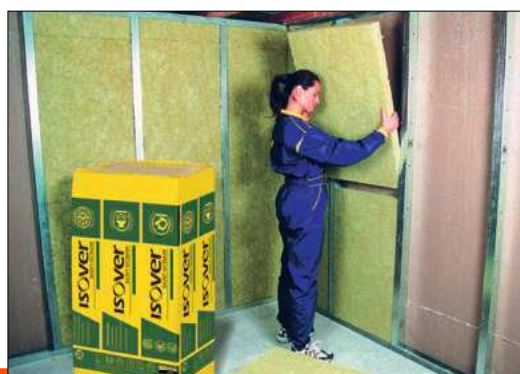
Ukázka aplikace výrobku Isover AKU
