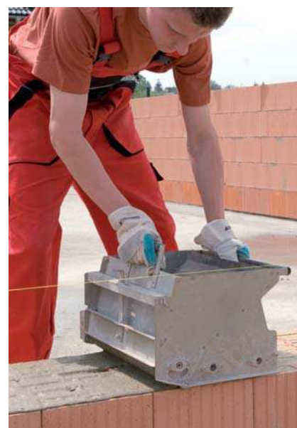
celoplošné nanášení vozíkem
