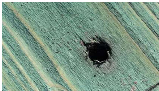
HOTOVO. VRUT JE ZAPUŠTĚNÝ DO ZÁKLADOVÉHO PRAHU
