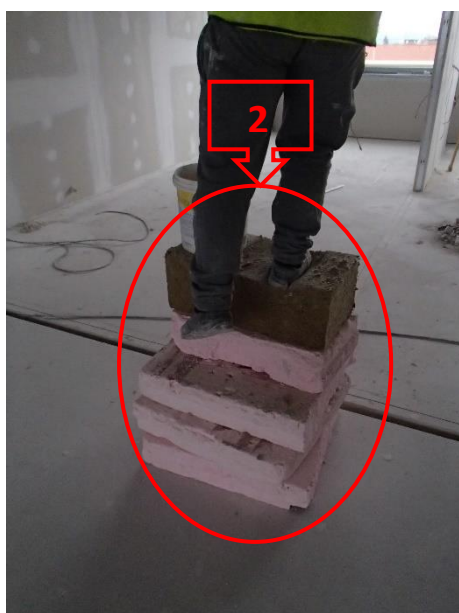
Obr. 44 - Pomocná konstrukce [O. Boroš]
