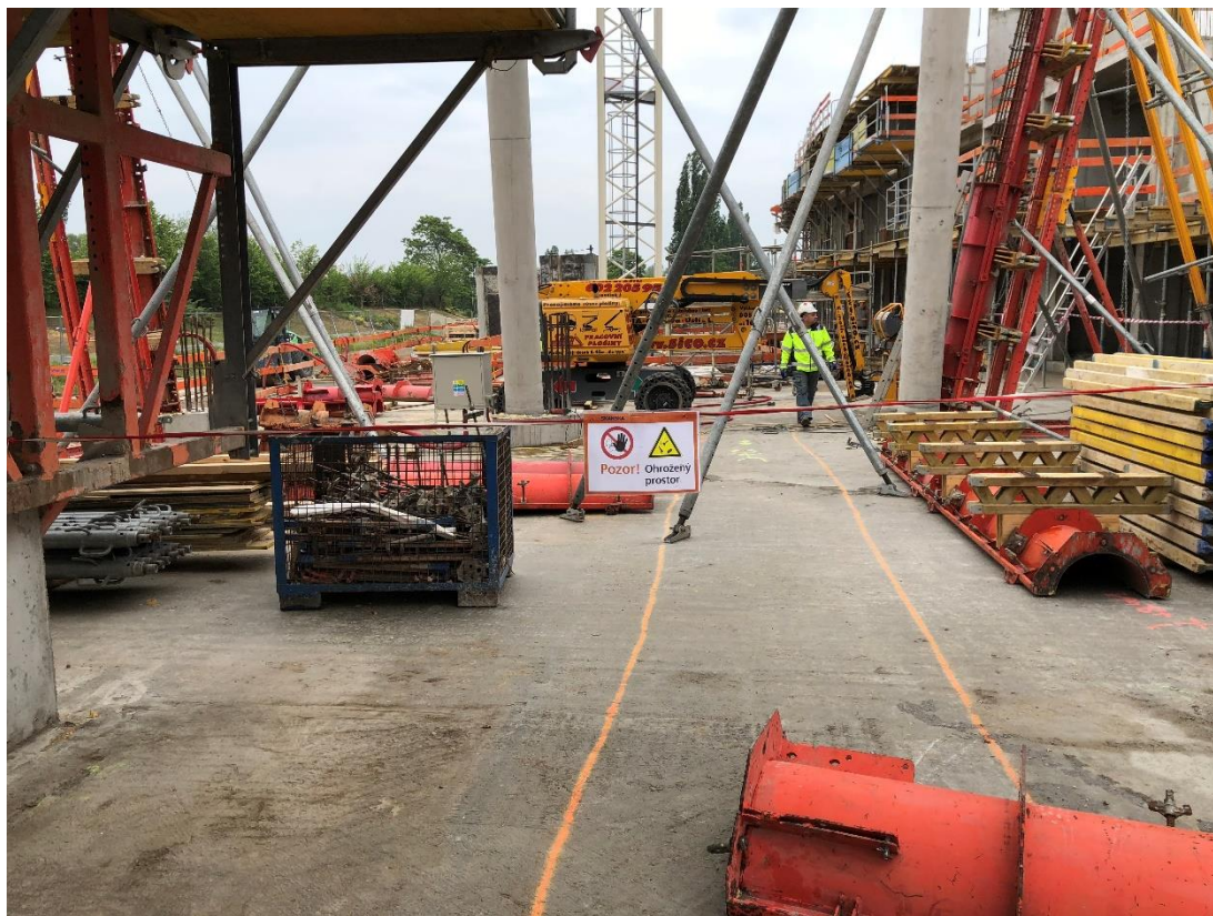
Obr. 28 - Uzavřený koridor z důvodu betonáže sloupů [O. Boroš]
