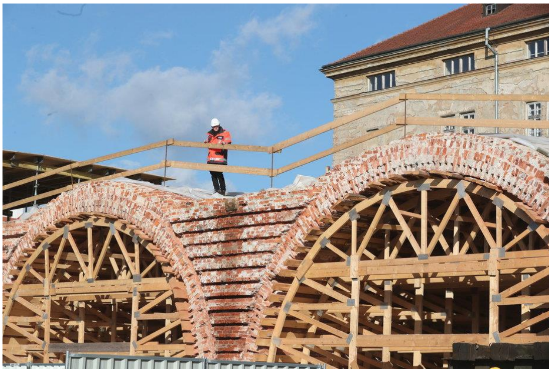
Obr. 19 - rekonstrukce Negrelliho viaduktu [alexandr malachovský]
