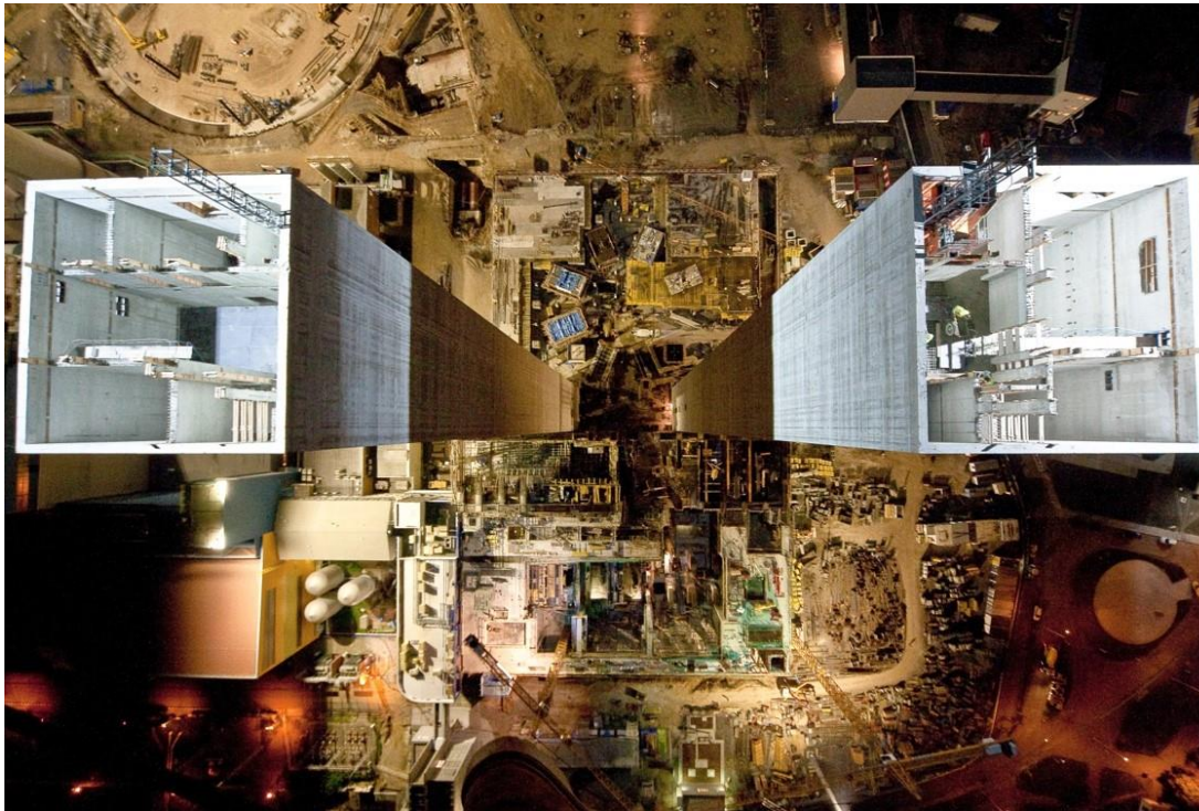
Obr. 34 - Výhled z kabiny jeřábu výšky 220 m [J. Tatar]
