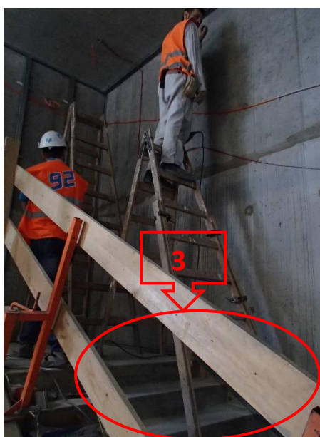
Obr. 45 - Pomocná konstrukce na schodišti [O. Boroš]
