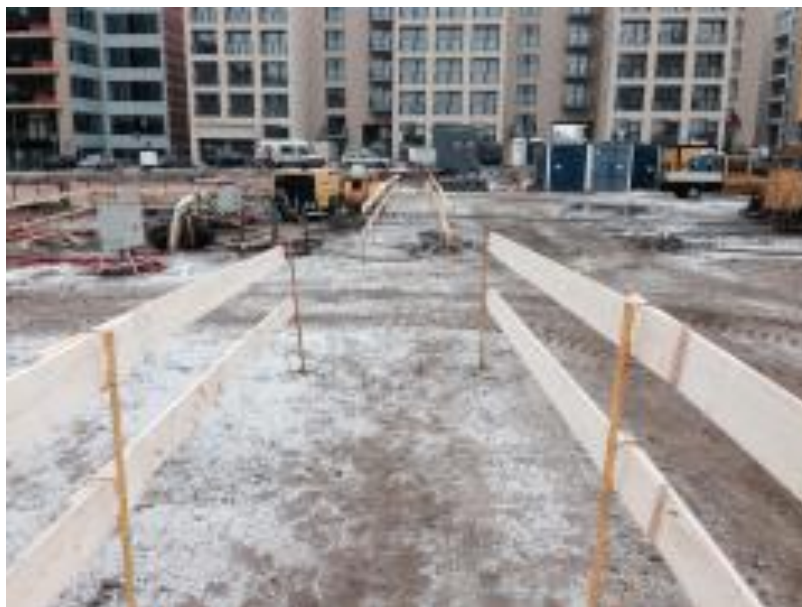
Obr. 27 - Pěší koridor na staveništi [O. Boroš]
