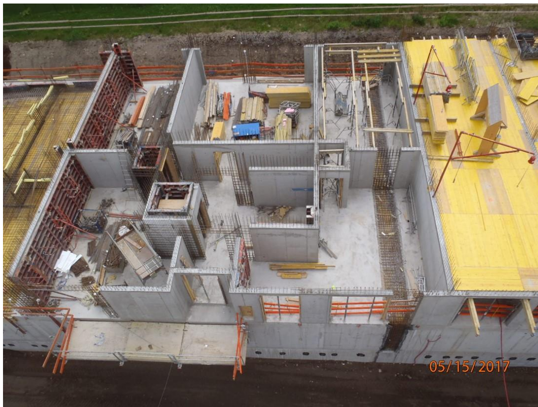
Obr. 31 - Výhled z kabiny jeřábu výšky 35 m [O. Boroš]
