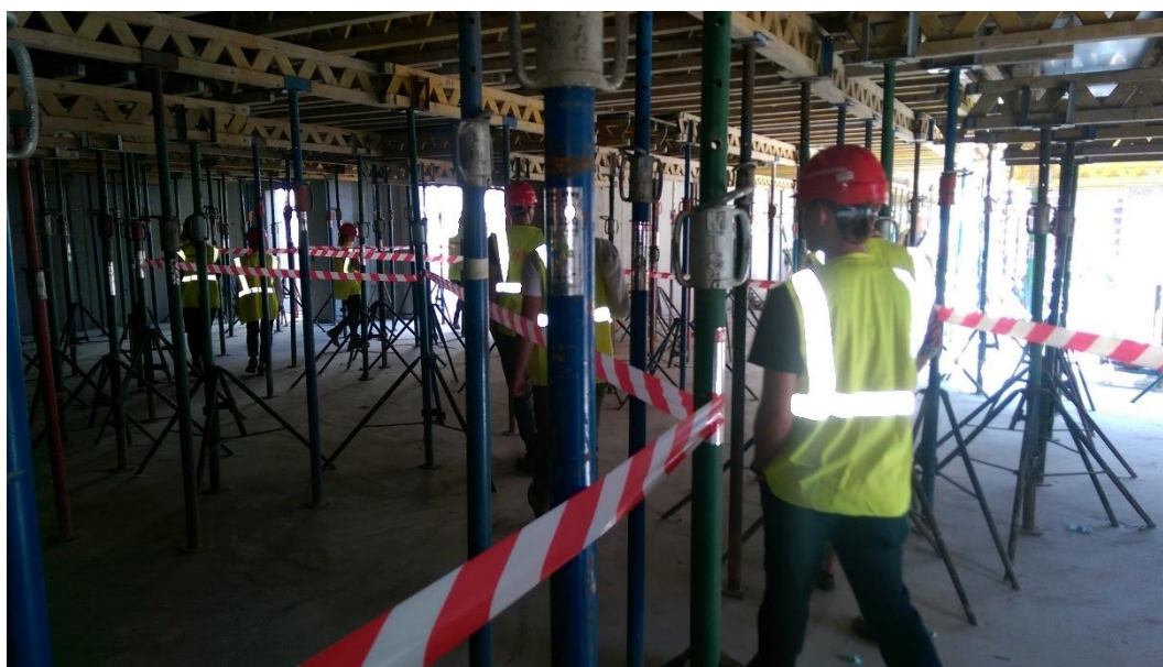
Obr. 29 - Vymezení pěších koridorů pod vodorovným bedněním [O. Boroš]
