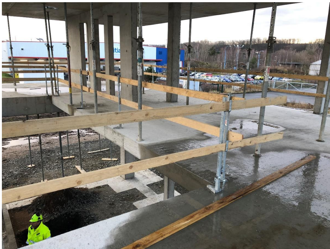
Obr. 39 - Pevné zábradlí – dobrá praxe [O. Boroš]
