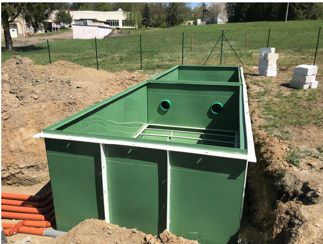
Obrázek 5: Biologický filtr před betonáží 30
